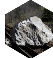
Chutes de blocs rocheux
